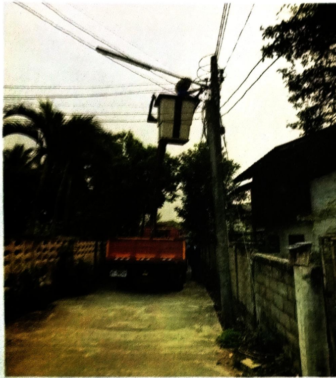
รูปภาพการติดตั้งไฟฟ้าสองสว่าง บ้านป่าบง หมู่ที่ ๓
